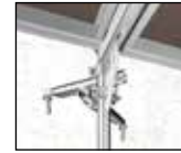
Dos tubos de anclaje unidos en forma de V con grapas estándar al pie del marco interior.
